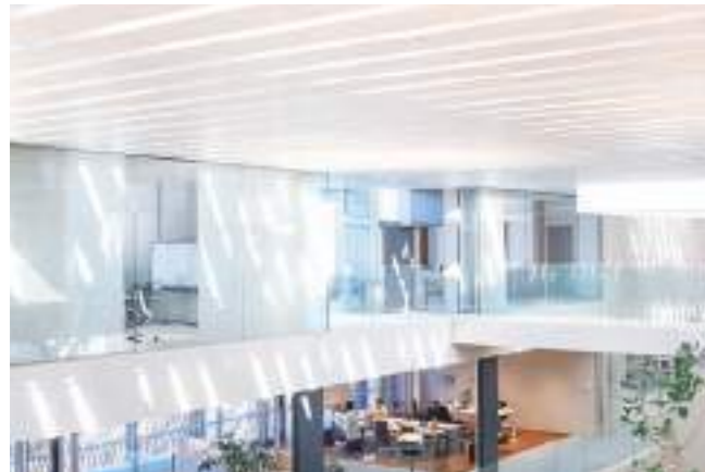
コンクリートの天井スリットが、光・風の通り道として機能。
