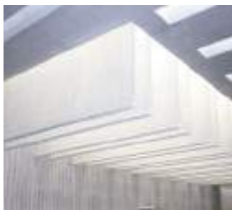
NIC天井の光拡散布は、国産の糸で作られた2色の生地にレーザー加工で穴をあけたデザイン。ここにも当社の加工薬剤が使われています。
