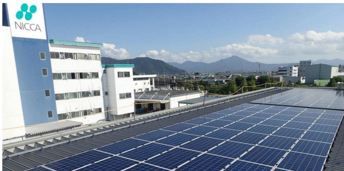
鯖江工場に設置されている太陽光発電設備。2018年(1月～12月)は約29,750kwh発電し、CO<sub>2</sub>排出量の削減に寄与しました。
