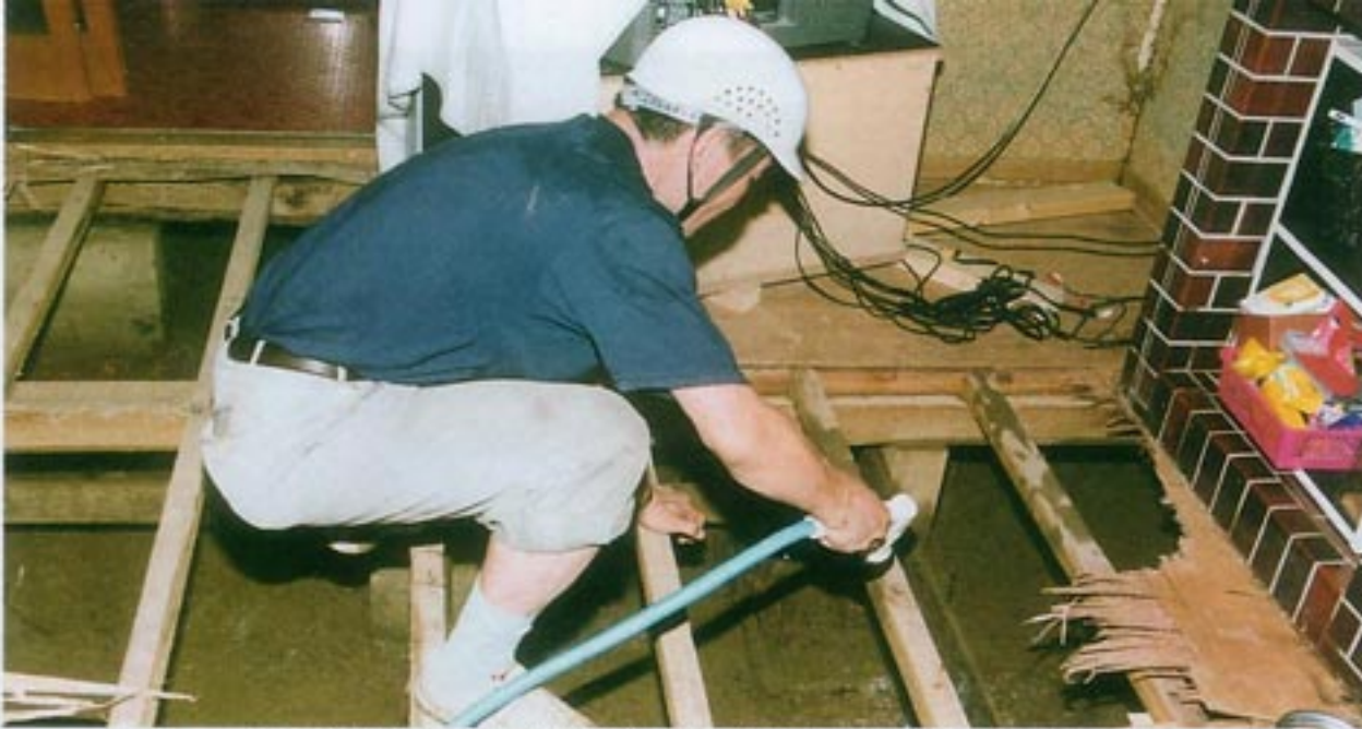
浸水被害に遭われたお宅に業務用消臭剤「クリーストAS-300」を散布
